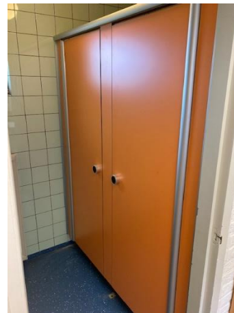
Nieuwe deuren kleutertoiletten
